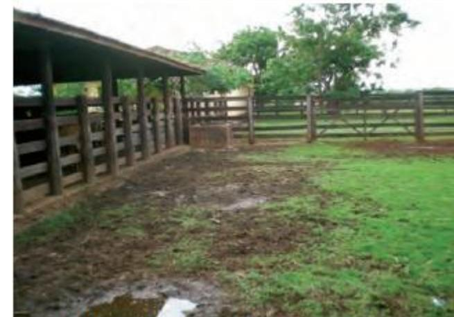
A AUSÊNCIA DE CALHA ALIMENTA A FORMAÇÃO DE LAMA
